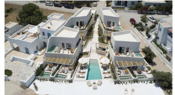
Αναβαθμισμένη αεροστεγανότητα κτιρίου
